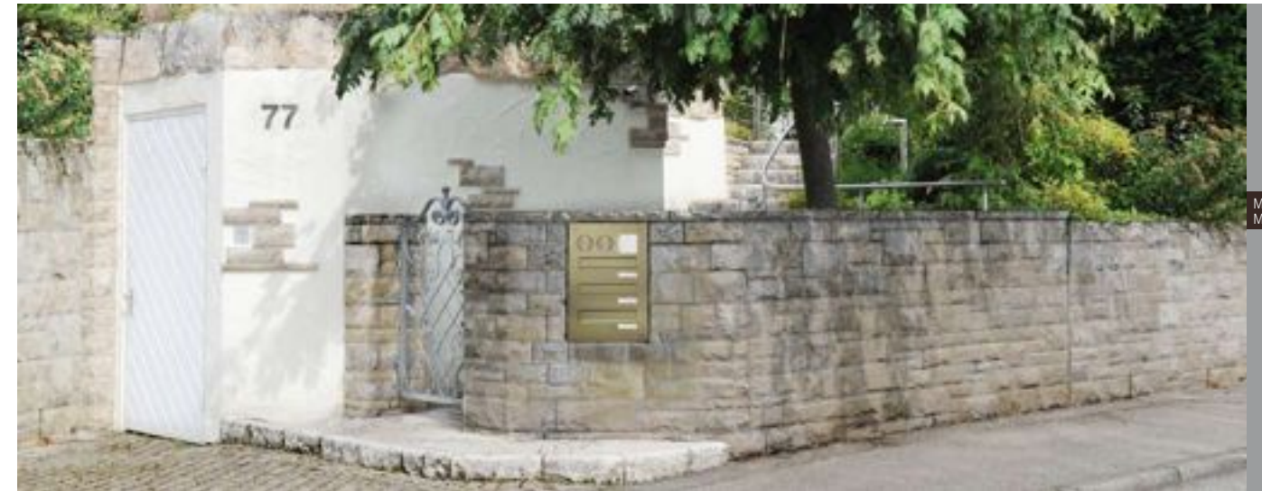
Mauerdurchwurf-Montage
